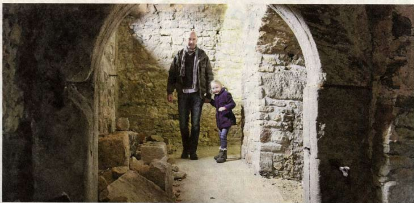
Spannend war für diese Gäste aus Arenshausen der Blick in den erstmals zugänglichen Gewölbekeller vom Herrenhaus. Foto: Reiner Schmalzl
