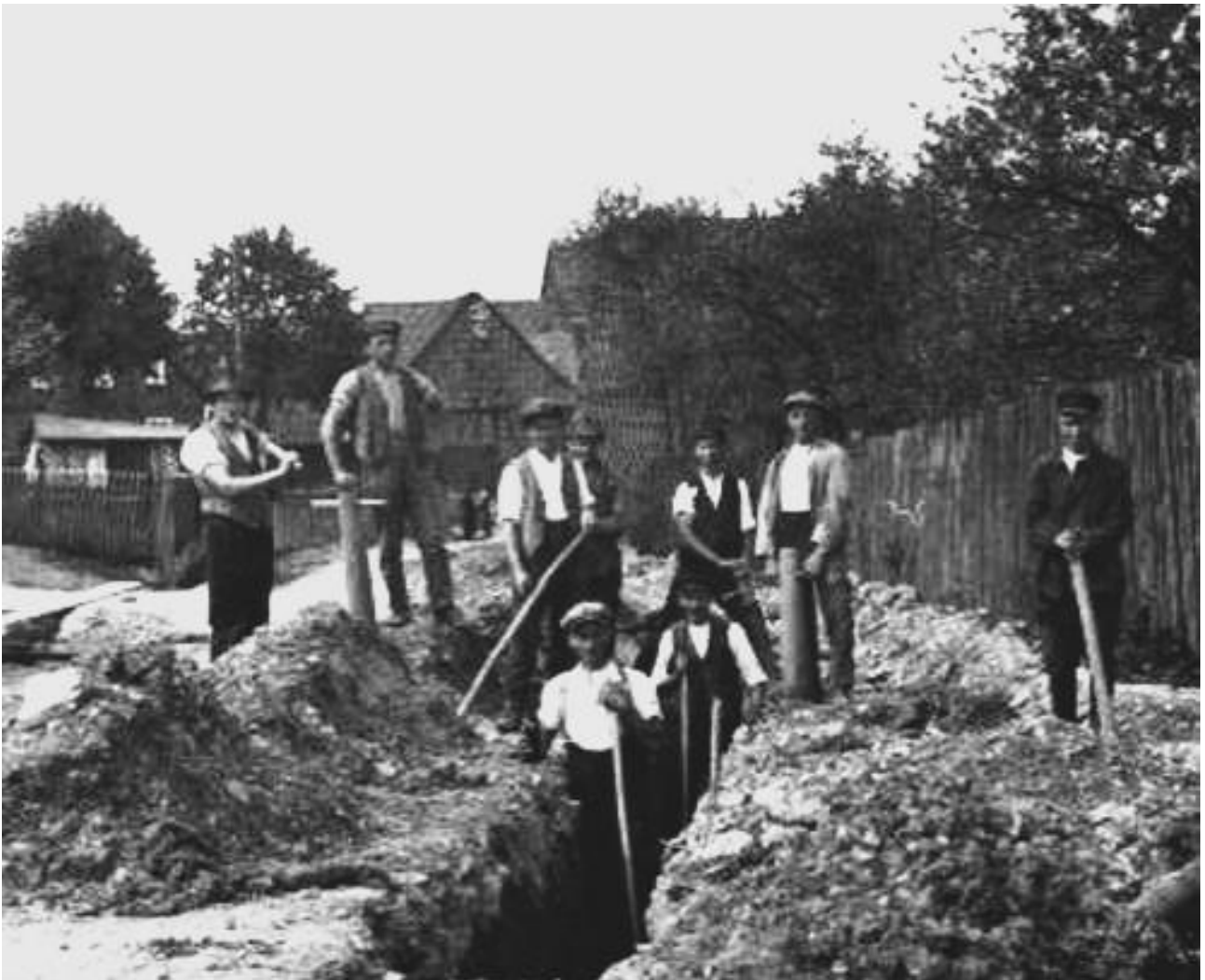
Abb.: Wasserleitungsbau in Kleinbartloff, Foto: Sammlung Alois Gille/ unveröffentlichte Dorfchronik
